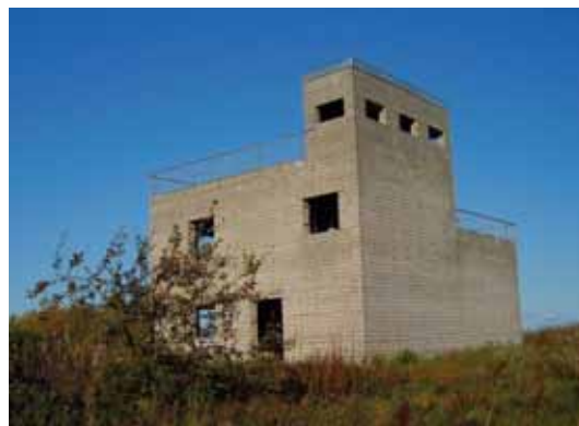
Linnukaitseala vaatlustorn. H. Treiali foto
