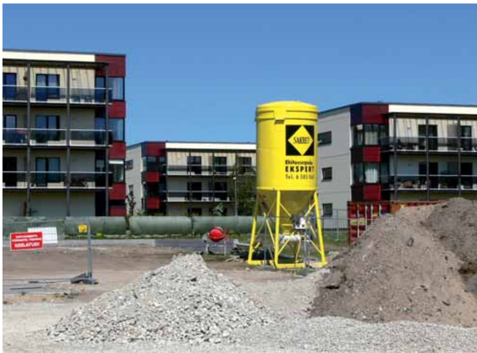
Sakreti kuivsegusilo ehitusplatsil
