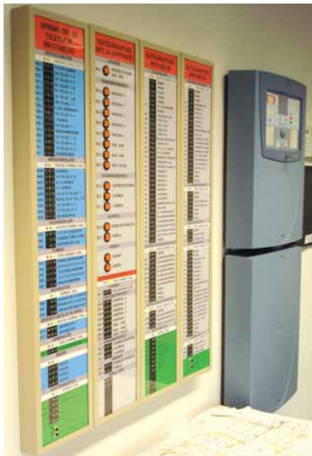
AS Hiiko valmistatud SPR tabloo, SÄ info- ja juhtimistabloom Tasku turvaruumis. Pildil on ka ATS (paremal)
