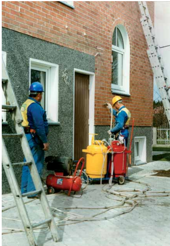
Välisseina õhkvahetäitmine soojustusvahuga
