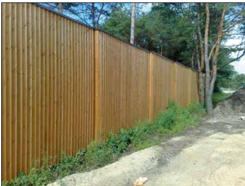
JOONIS 3: EESMÄRKI MITTETÄITEV MÜRATÕKE
