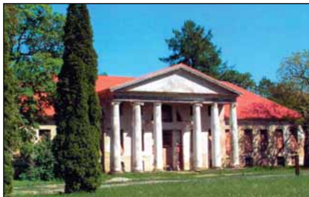
MÕISA PEAHOONE ESIFASSAAD PÄRAST UUE KATUSE VALMIMIST
