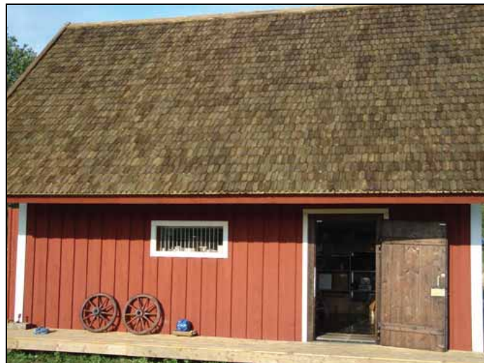
TÕRVAÕLILAADSE PUIDUKAITSEVAHENDIGA IMMUTATUD KATUS
