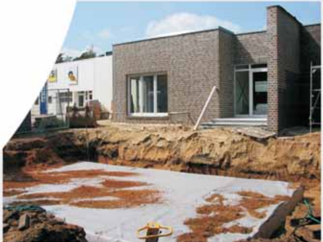
Foto 3. Geotekstiiliga ümbritsetud sademeveemahuti enne tagasitäitmist
