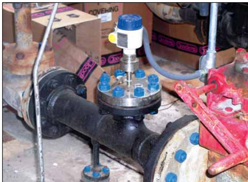
JOONIS 4. SmartCET-i ANDUR PROTSESSI PAIGALDATUNA
