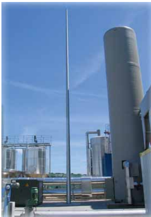
JOONIS 2. TERASEST TELE-PIKSEKAITSEMASE KASUTAMINE GAASIMAHUTI JA VÄÄVLITUSSEADME KAITSEKS
