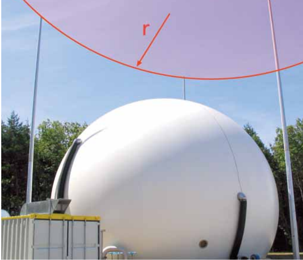
JOONIS 3. PIKSEKUULIMEETODI KASUTAMINE KÄÄRIMISMAHUTI PÜÜDESÜSTEEMI KAITSEALAS
