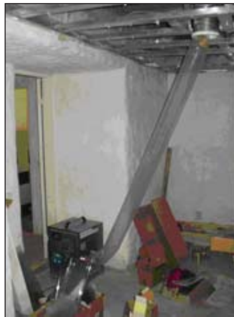
FOTO 4. ROOTORKUIVATI. NIISKE ÕHK JUHITAKSE APARAADIST VÄLJUVA KILETORU KAUDU VENTILATSIOONISÜSTEEMI
