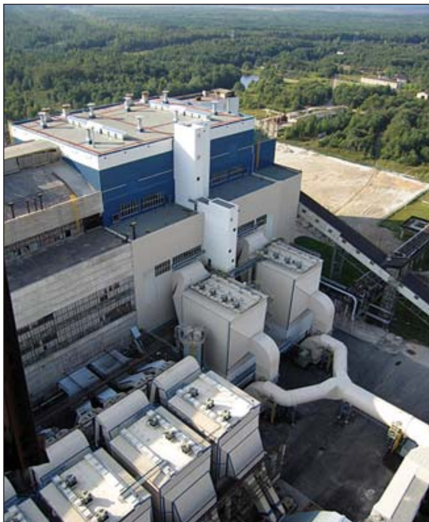
EESTI ELEKTRIJAMA REKONSTRUEERITUD 8. ENERGIAPLOKK
