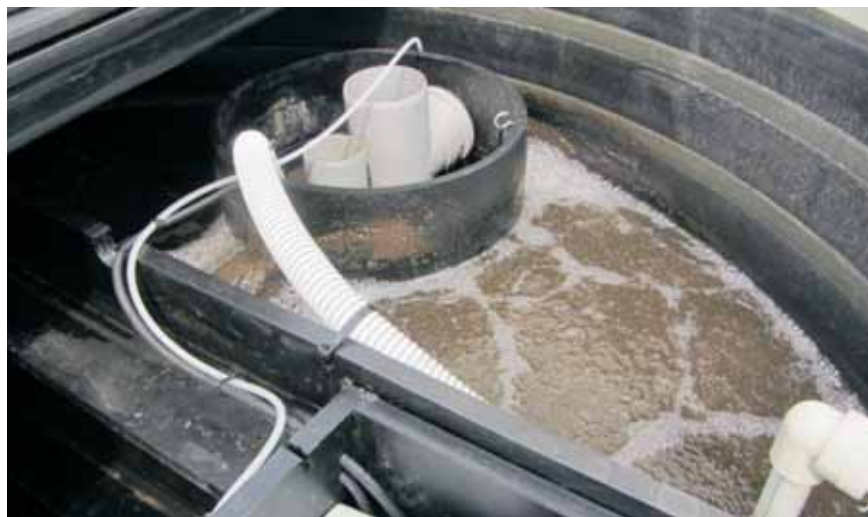
Joonis 3. Katsepuhasti BioFix-1AP õhustuskamber
