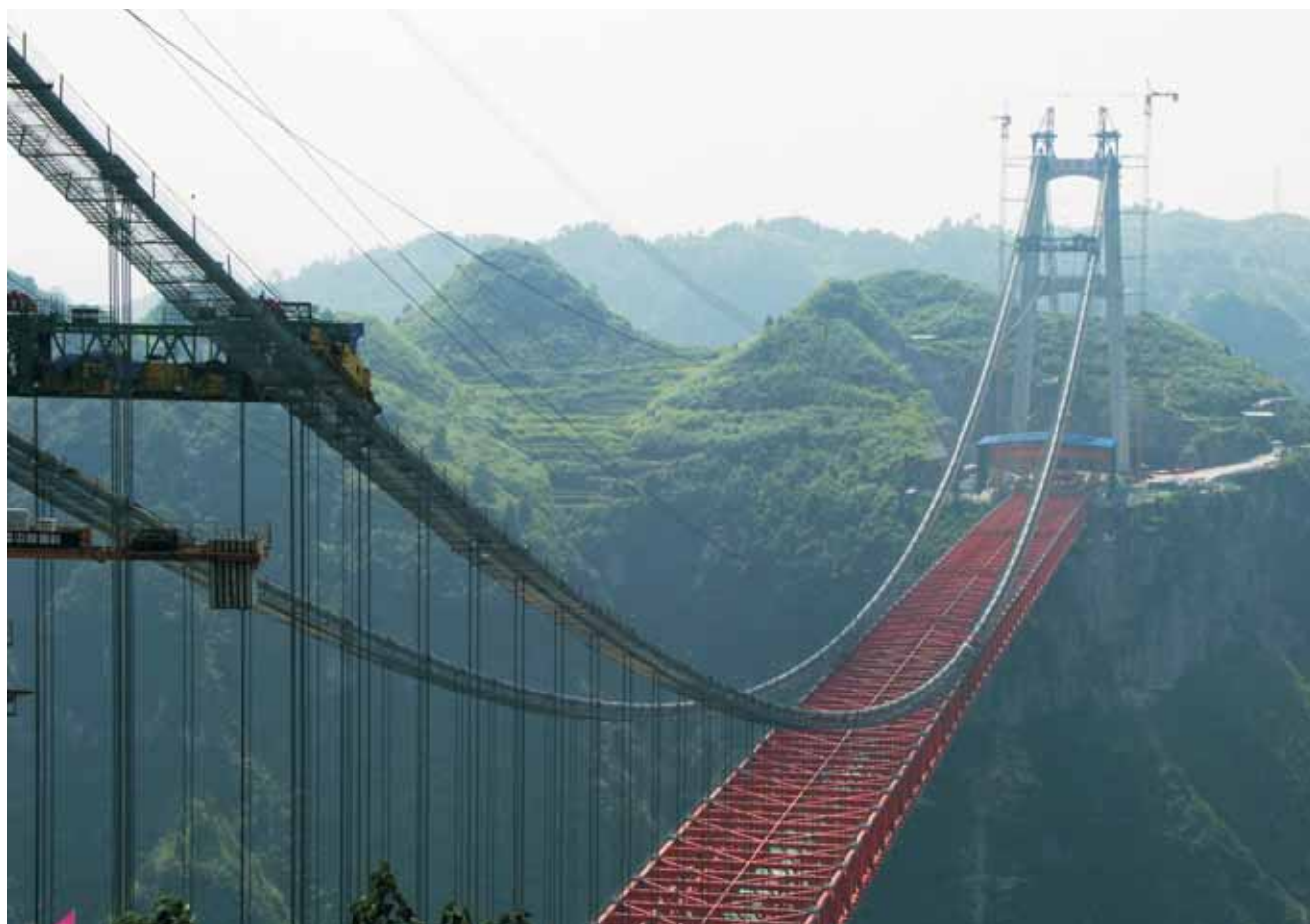
Silla terassõrestikte ehitamine, taamal paistab põhjapoolne kõrge püloon [2]
