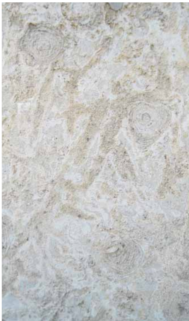
Foto 5. Dolomiidistunud sibulpaas kuivuslõhedega, mis täitunud tumedama lauspuurde settega. Ohtja karjäär, Rootsiküla lade, Vesiku kihid. Paeplaat seinas, Tallinn, Estonia puiestee 3
