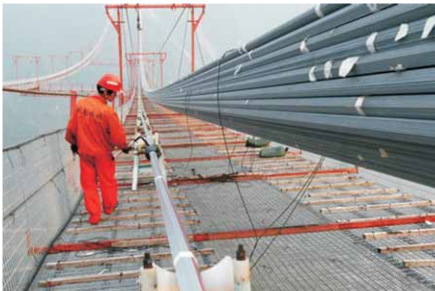
Kandetrossi osatrossid on kuusnurksed, et neid saaks tihedamalt kokku suruda [2]
