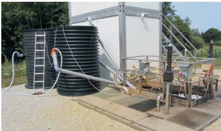
Joonis 1. Katsetatud puhastid BioFix-1AP (tagaplaanil) ja BioFix-1K Raasiku asula konteinerreoveepuhasti BioFix Biocon kõrval
