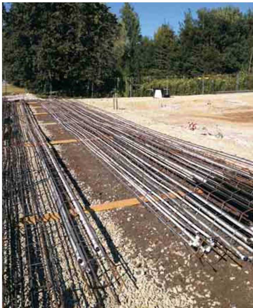
Pe-Xa-torudega varustatud sarrused ootavad energiavaiade valamist
