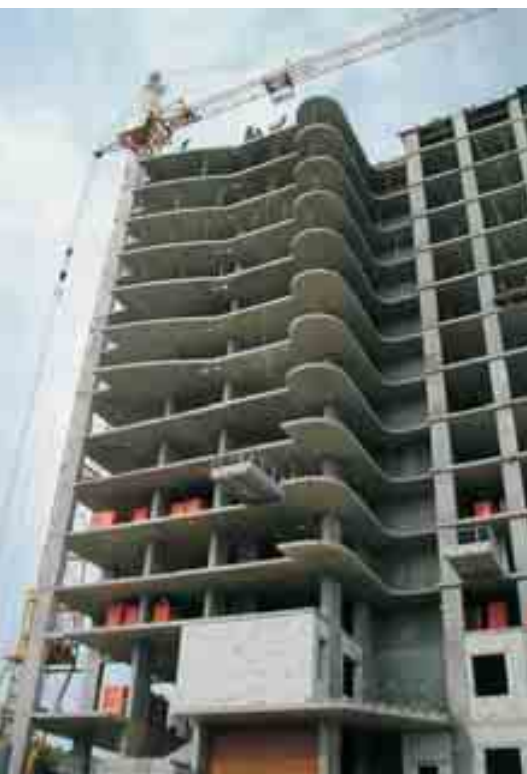
Mitmekorruselise elamu välisseinte ehitamine Kiievis AEROC-plokkidest
