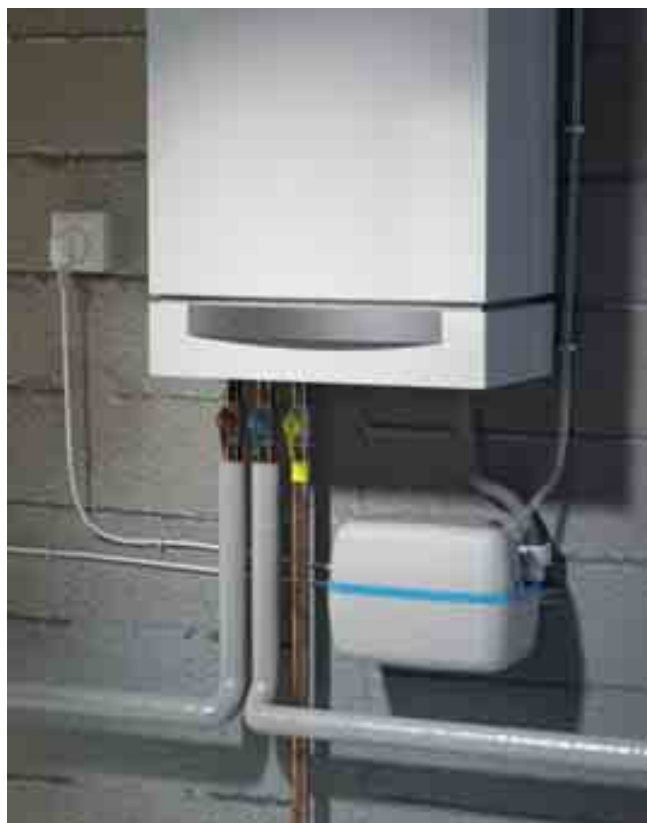
Kondensatsioonivee pumpamiseks mõeldud SANICONDENS
