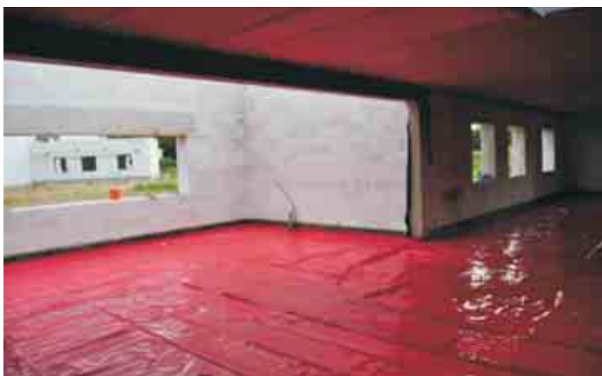
Radoonikile paigaldamine polüstürool-soojustuskihile, mis kaetakse ka pealt polüstüroolsoojustusega
