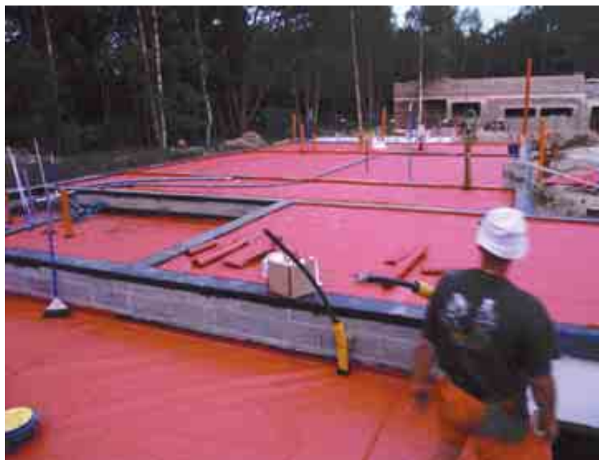
Radoonikile paigaldamine ja kommunikatsiooniläbiviikude tihendamine
