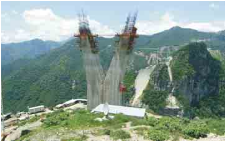
Durango-poolse pülooni (nr 5) alumise osa ehitamine. Pülooni jalamil paistab ehituskontor Foto: Grupo Triada/SCT
