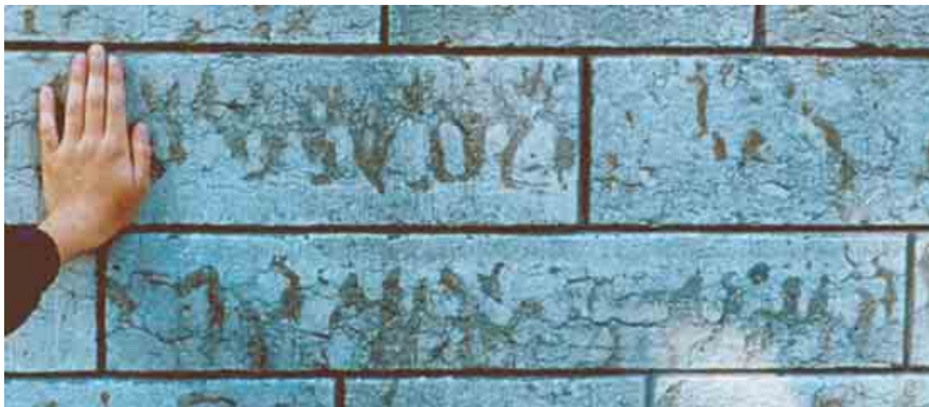
Paeplokid 1930ndatel rajatud hoones Tõnismäel. Tihedaim püstakulisus on Laksu punases, kus kahe kp püstakud põimuvad, ulatudes kohati üksteise sisse, lamava, enam kõvastunud kihini jõudes on sageli kõverdunud. Esineb U-kujulisi püstakuid
