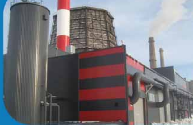
VKG Soojus ASi Ahtme 100 MW katlamaja
