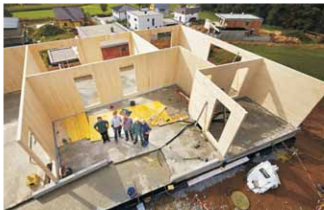
Joonis 2. Ristkihtpuidust kandvate seintega elamu ehitamine
