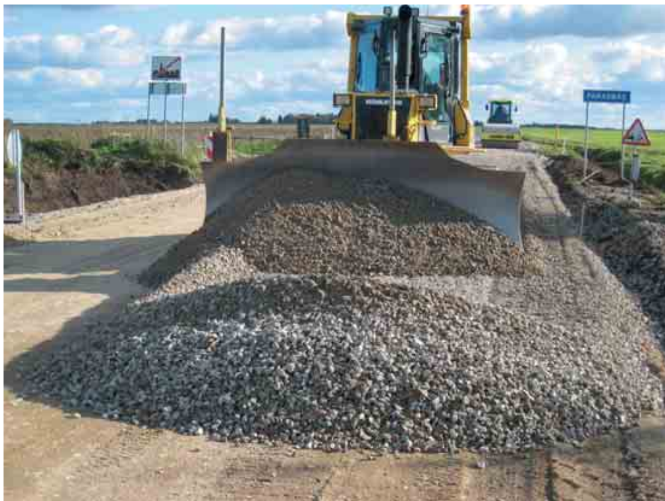
Katselõigu betoonkillustikaluse ehitamine
