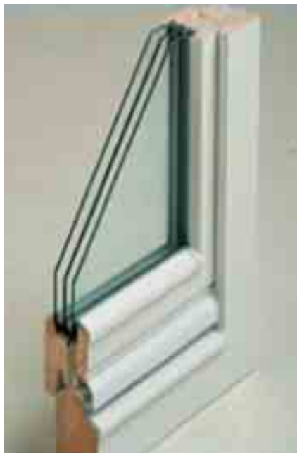
Joonis 6. Puitakna ristprofiil [13]
