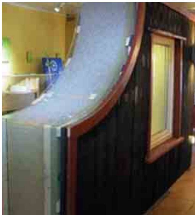
Joonis 5. Passiivmaja tselluvillaga soojustatud sein [10]
