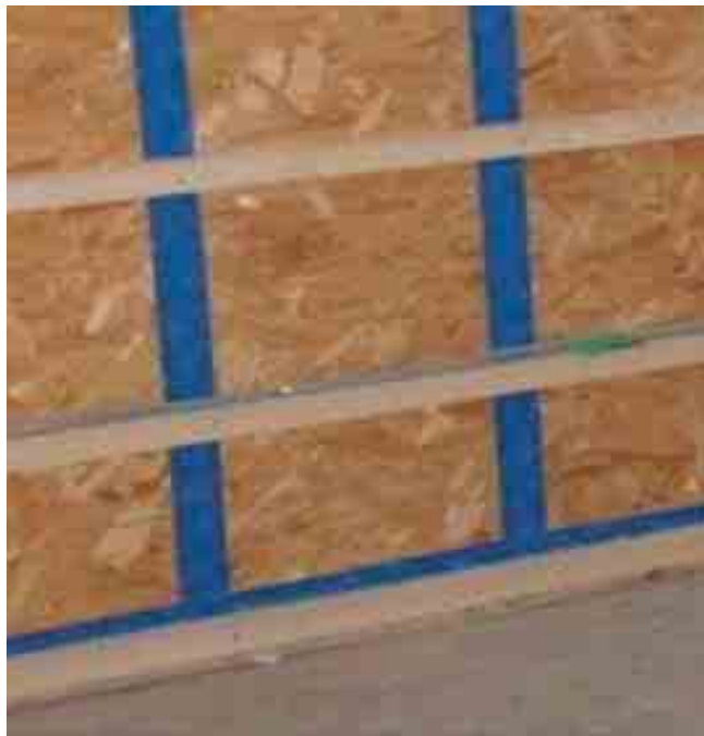
Joonis 4. Teibitud liitekohtadega OSB-plaadid [7]
