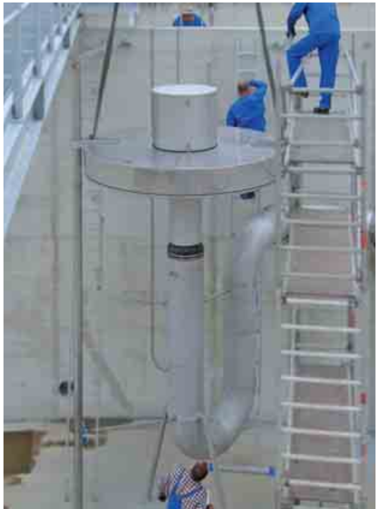
Joonis 3. Teleskoopülevoolu Lineardekanter® (1 400 m³/h) paigaldamine. Dekanteripäised ujuvad alati veepinnal. Reovee puhastamise ajal on nad suletud ning avanevad ainult tühjendusfaasi ajaks. Vesi pääseb välja, põhjustamata mingit imemistoimet, keerist ega muda väljakannet
