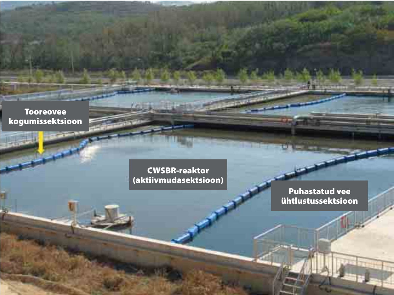
Joonis 2. Hiinas paiknev CWSBR-puhasti (jõudlus 130 000 ie) koosneb neljast moodulist, millest igaüks jaguneb kogumissektsiooniks, CWSBR-reaktoriks ja ühtlustussektsiooniks. Iga moodul võib töötada omaette või koos teistega. Kui piirkonna rahvaarv peaks kasvama, on võimalik mooduleid lisada
