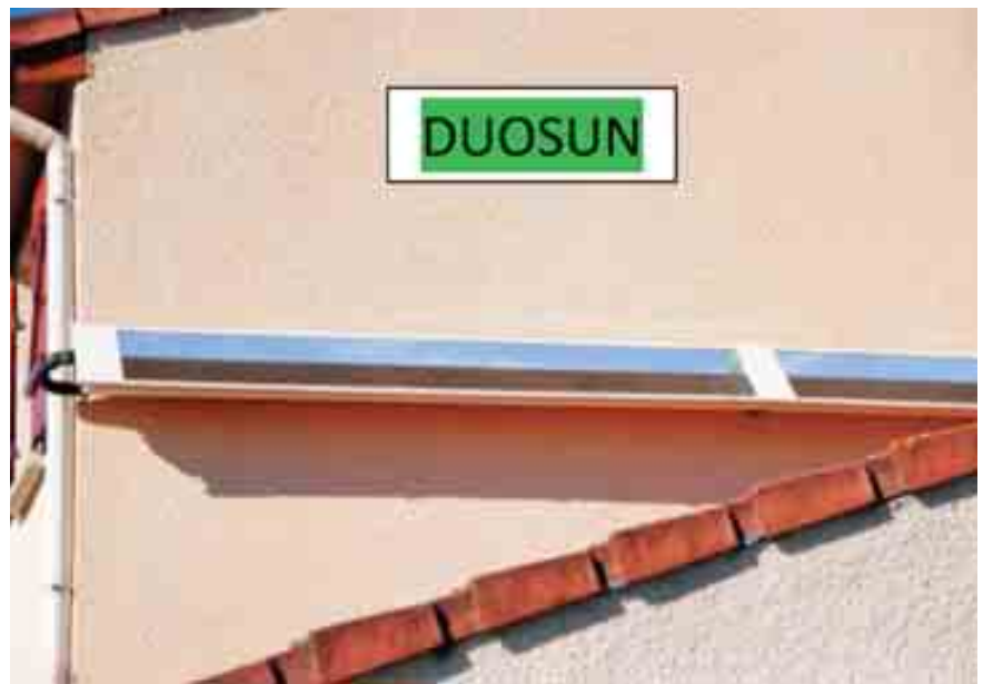
Päikesepaneel Duosun võib paikneda aknapõsel või räästa servas
