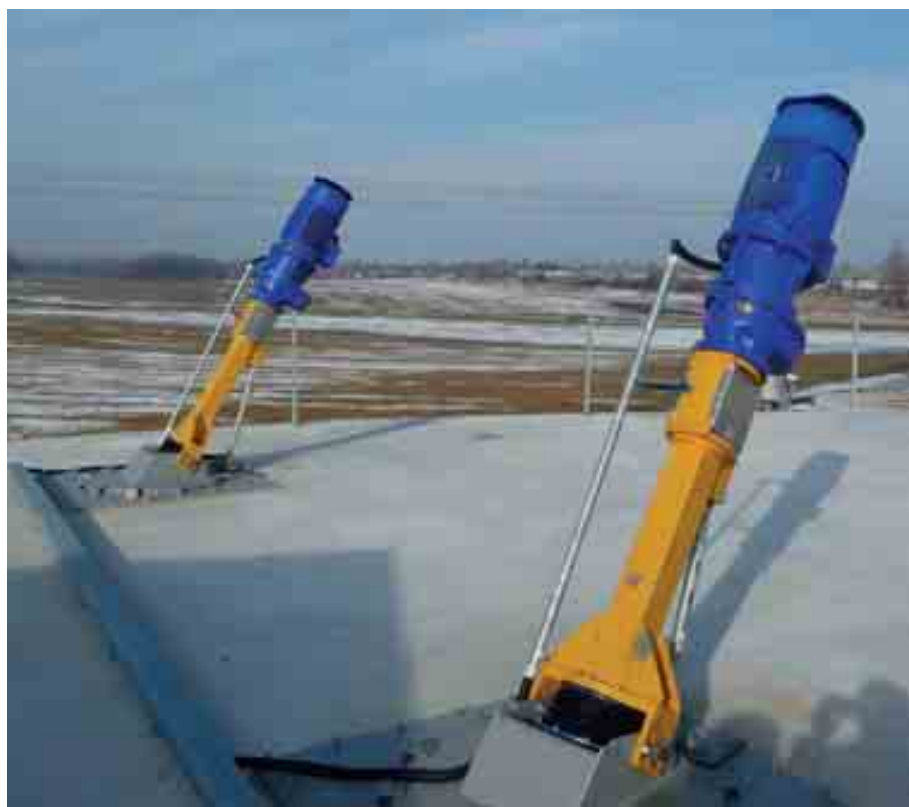
Joonis 3. Seguriajamid Bad Dürrenbergi biogaasijaama katusel
