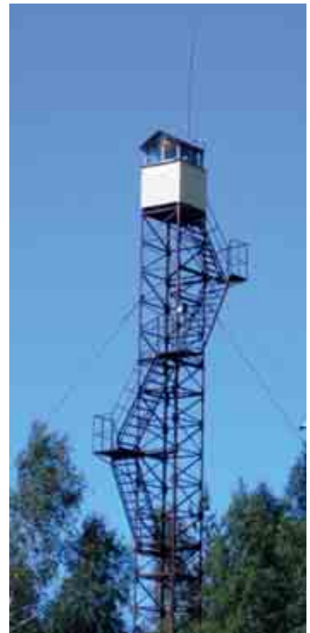
Vaatlustorn, kus tugeva tuule korral heisatakse tööde peatamist nõudev punane lipp
