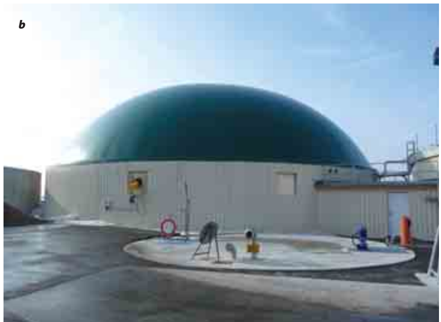
Joonis 2. Firma SBBiogas GmbH ehitatud biogaasijaam Saksamaal, Bad Dürrenbergis: a on jaama tehnoloogiaskeem. Toormed (rohtne biomass ja läga) sisestatakse rõngakujulise püstkääriti sisemisse ossa ja kääritatakse 40 päeva temperatuuril 50 °C. Seal tekib 90 % biogaasist. Seejärel juhitakse käärimine mass veel 40 päevaks välimisse ossa (temperatuur 38 °C) ning lõpuks järelkääritisse. Tänu kääritite kompaktsusele ja tõhusale isolatsioonile (soojusjuhtivustegur: 0,4 W/m²K) kulub käärimistemperatuuri hoidmiseks vaid 12,5–20 % toodetud energiast isegi siis, kui välistemperatuur on –20°C; b on ujuvkatusesega järelkääriti
