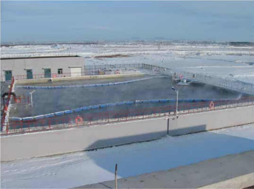
Joonis 2. CWSBR on täistehnoloogilise annuspuhasti tiigivariant, mis rahuldab reovee kõrgeid puhastusnõudeid isegi -30 °C juures Sise-Mongoolias
