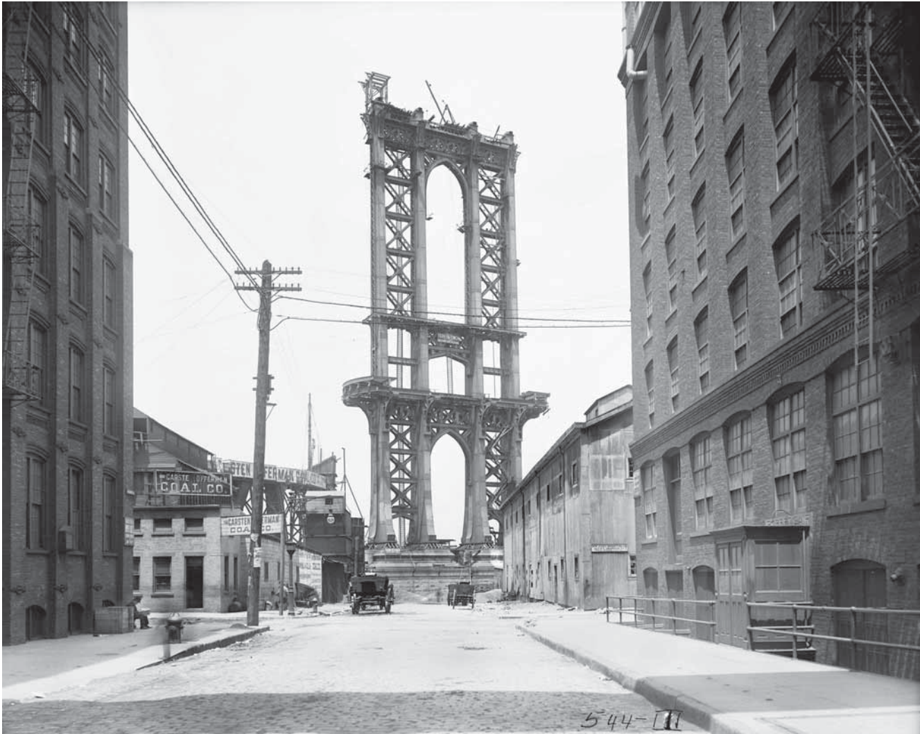
Foto aastast 1908. Brooklyni-poolne pülo on valmis saanud ja ootab kandetrosside paigaldamist. Foto on teinud Eugene de Salignac ja selle allkiri on "Manhattan Bridge, from Washington Street looking west, Brooklyn, June 5, 1908" Foto: New York City Municipal Archives
