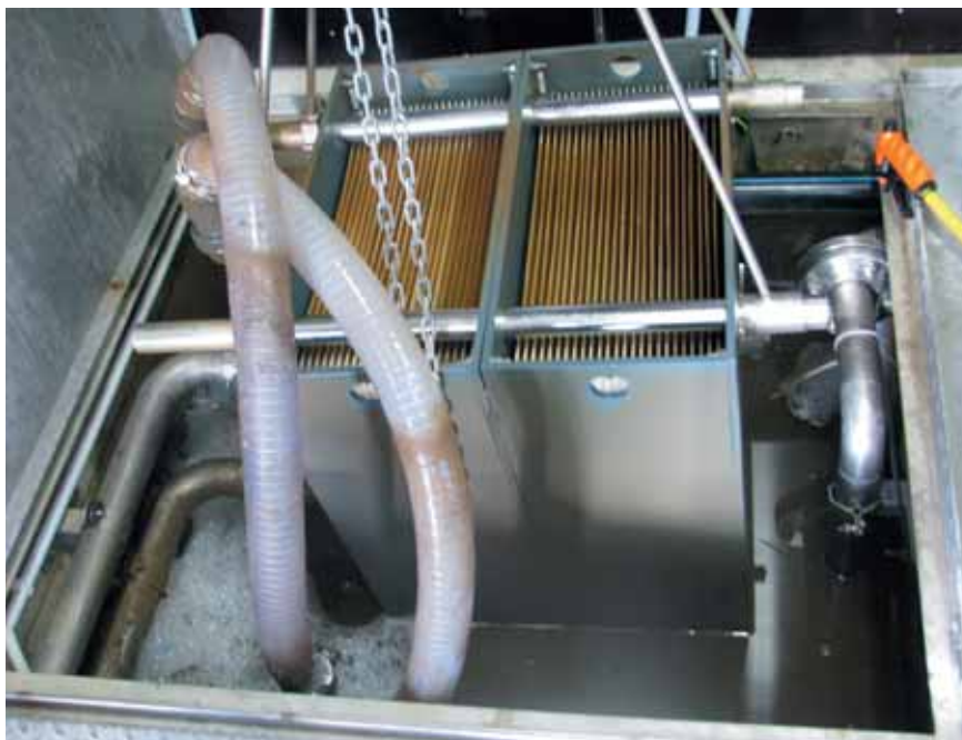
Joonis 5. Membraanseadme väljatõstmine
