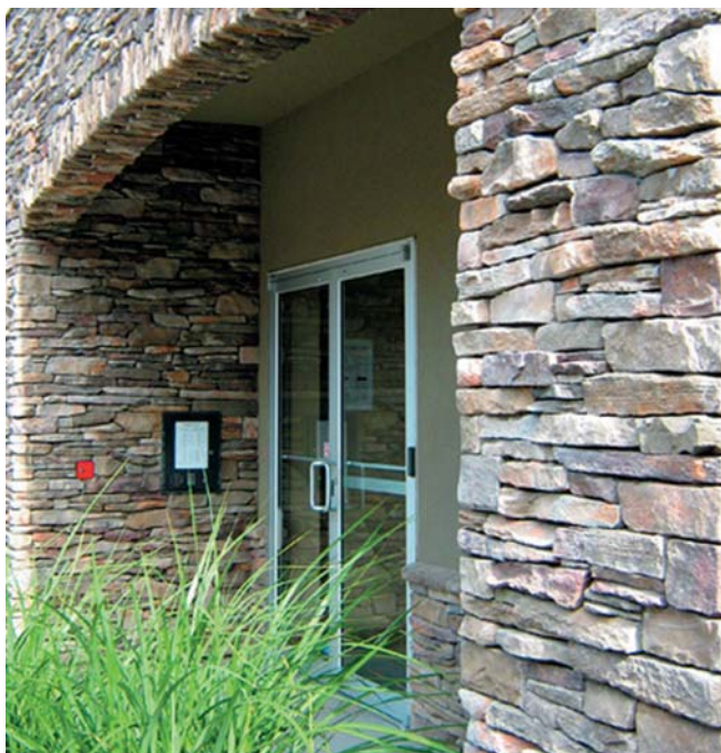
PUR-kõvakattetehnoloogial viimistletud maja kiviimitatsiooniga kaetud fassaad
