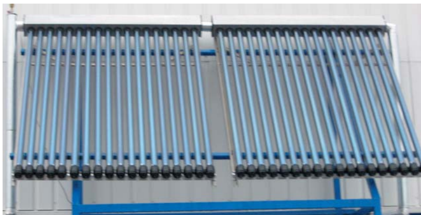
Joonis 2. Eestis kasutatav Hiina päritolu vaakumtorukollektor SPA-58-1800
