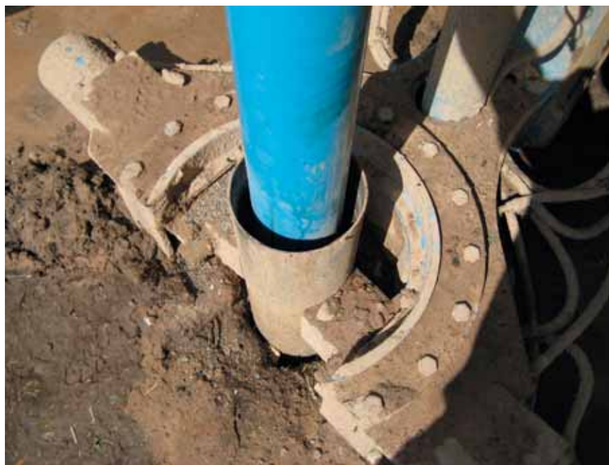
Joonis 4. Kahe rootoriga puurides on võimalik puredat kivimit toetavat juhttoru, mis hiljem eemaldatakse, tsementimise ajaks maa sisse jätta
