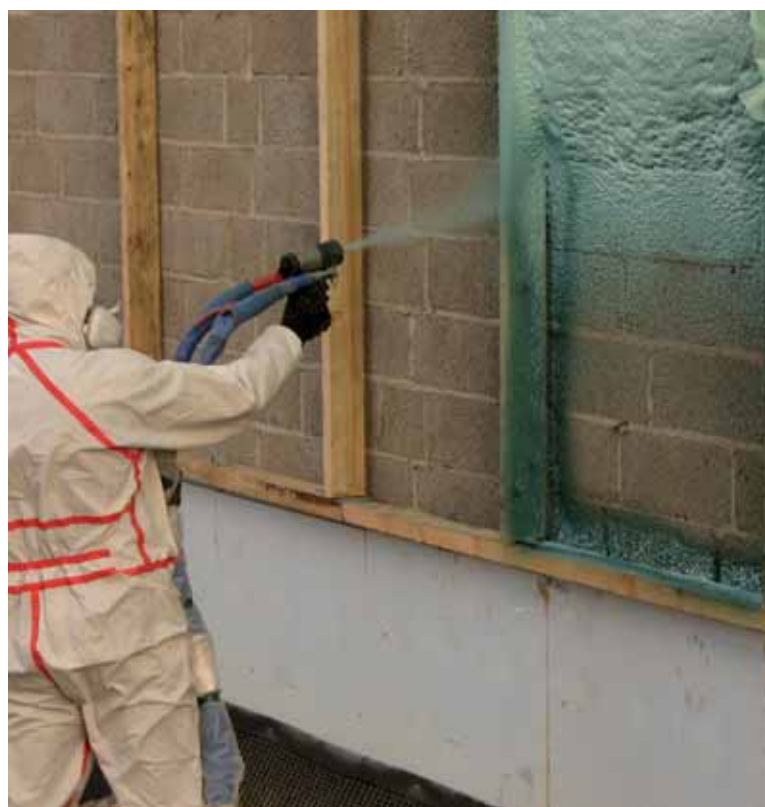
Joonis 3. PUR-soojustusvahu pihustamine
