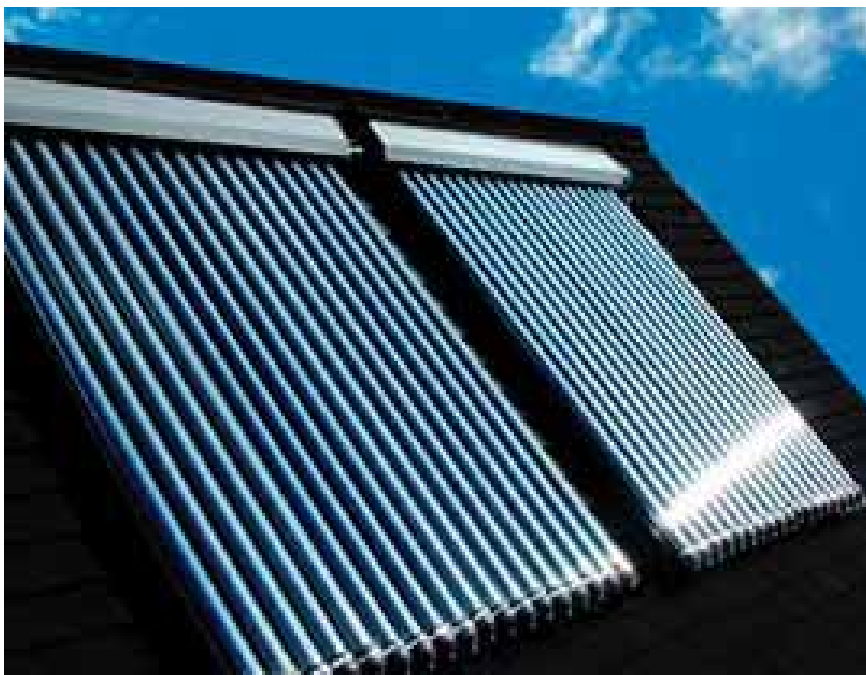
Joonis 4. Vaakum-päikese kollektorid on plaatkollektoritest tõhusamad ja ilmastikukindlamad
