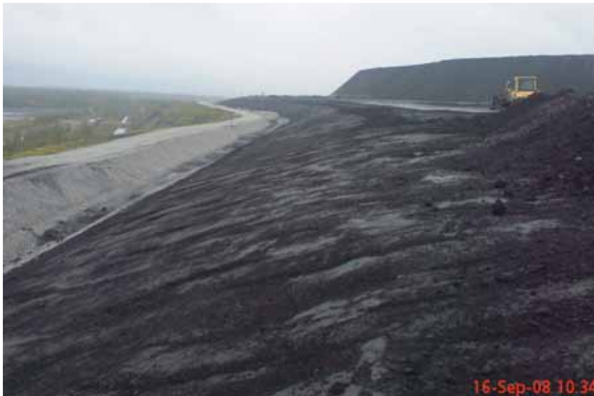
Kohtla-Järve poolkoksimaagi nõlv on katmiseks ette valmistatud
