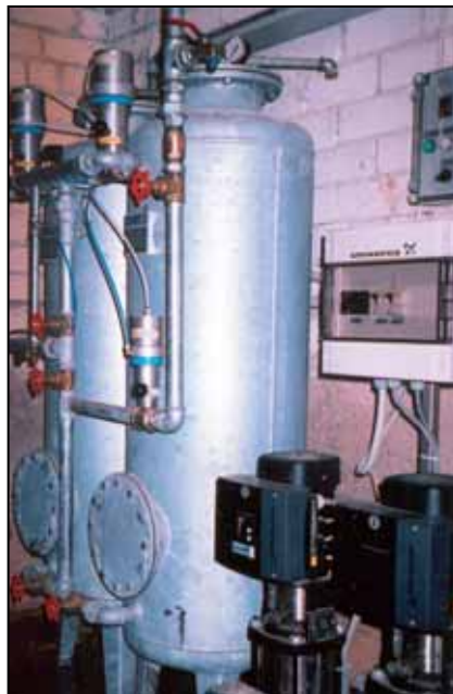
KÕO JOOGIVEEPUHASTI TÄISAUTOMAATNE PAARISSURVEFILTER 402 PRA JA RÖHUTÖSTESEADE Grundfos Hydro-MultiE 2 CRE 5-8
