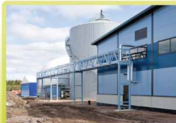
Satakierito OY 2007.a sügisel käiku antud biogaasijaam Kõyliös (Soome)
