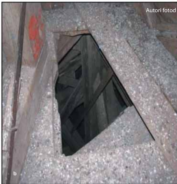
Joonis 9. Sangaste kirik: a katuseetarindid; b torni katab linnusõnnik (Kevad, 2009)
