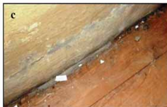
Joonis 4. a Vee kapillaarne liikumine ning soolade kogunemine ajaloolise hoone müüritisel [4]; b Rannu kiriku seina alumine osa on kaetud vetikatega ning põrand on pehkinud; c Urvaste kiriku seina ja põranda liitekoht on niiskuse tõttu mädanenud
