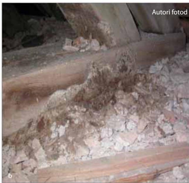
Joonis 10. Rannu kirik: a putukate ning b seente (majavammi) kahjustatud katusetarindisõlm
