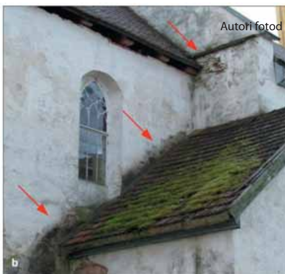
Joonis 11. a Urvaste kiriku idafassaad: katuseviilu katteplekkide veeninad on liiga lühikesed; b Puhja kiriku kooriruum (vaade kirdest): katusele voolav vesi on kahjustanud seina, sest katuse ja seina ühenduskohas pole vihmaveerenni ega seina kaitsvat plekki
