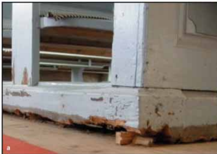
Joonis 5. a Sangaste kiriku pingid on pehkinud; b Rannu kiriku põranda lõunapoolsel osal oli näha seen- ja putukakahjustust
