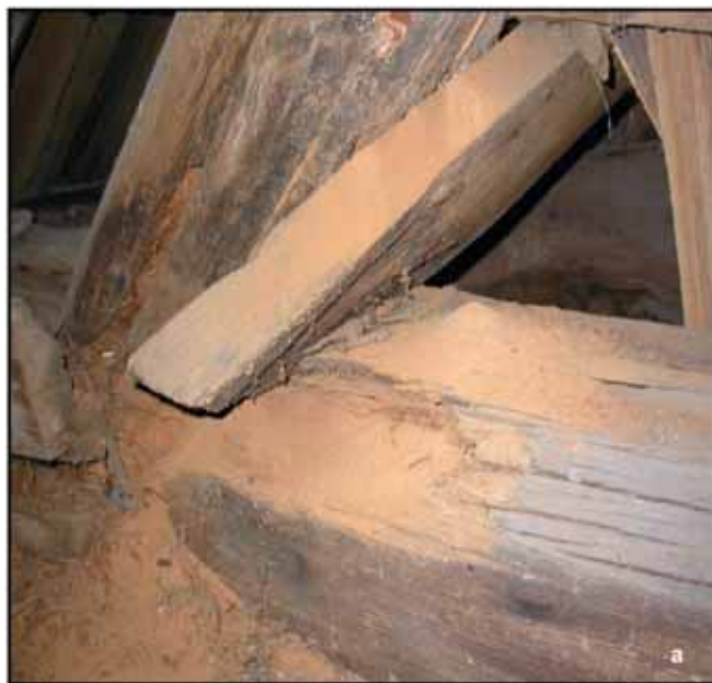
Joonis 10. Rannu kirik: a putukate ning b seente (majavammi) kahjustatud katusetarindisõlm
