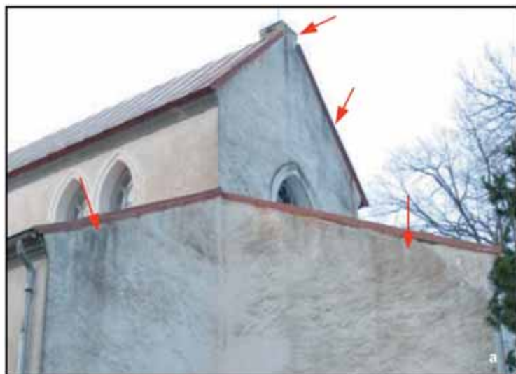
Joonis 11. a Urvaste kiriku idafassaad: katuseviilu katteplekkide veeninad on liiga lühikesed; b Puhja kiriku kooriruum (vaade kirdest): katusele voolav vesi on kahjustanud seina, sest katuse ja seina ühenduskohas pole vihmaveerenni ega seina kaitsvat plekki
