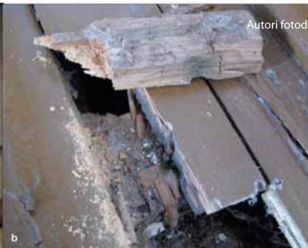
Joonis 5. a Sangaste kiriku pingid on pehkinud; b Rannu kiriku põranda lõunapoolsel osal oli näha seen- ja putukakahjustust
