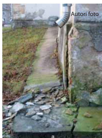
Joonis 3. a Sangaste kiriku sokkel; b vee liikumine vanas hoones (kui põrandale pannakse tihe kate, suureneb vundamendi ja seinte niiskuskahjustus; näidatud on vee kapillaartõusu ning soolade liikumist ja ladestumist vanades müüritistes) [4]; c sillutise korral liigub vesi läbi müüritise ning aurustub selle pinnal [5]
