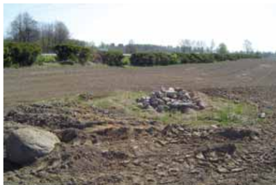
Joonis 1. Maa Kukruse kaevanduse kohal. Taamal heki taga Narva maantee Kukruse–Jõhvi lõik. Esiplaanil – strekitervikute peal olev kvaasistabiilne maa, mida iseloomustavad põllukividega täidetud kohtvaringud. Kivikuhila taga näha olev vajum on ohtlik ala (tabel 1). Sellest kaugemal on langetatud maa, mis taamal toetub suhteliselt hästi laotud täiteriitadele
